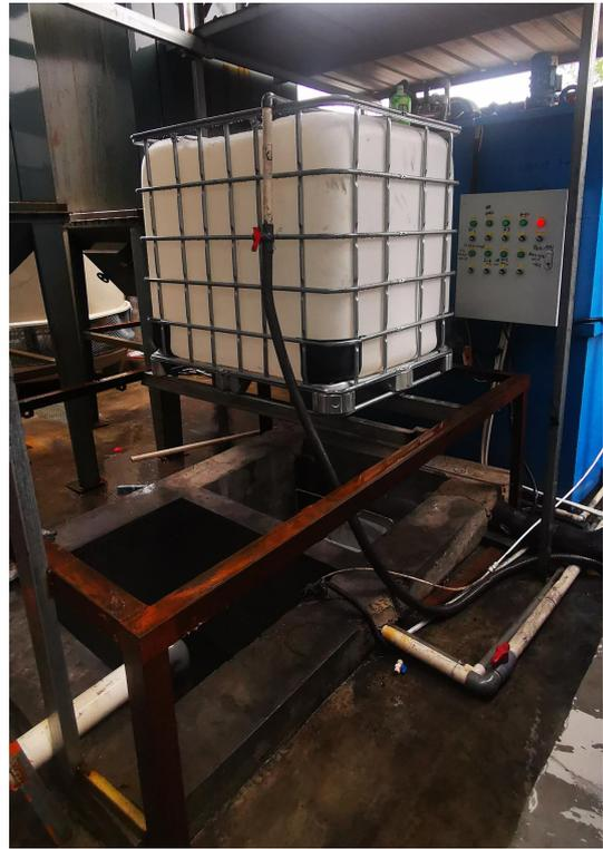
生产废水回水处理设施（混凝沉淀+陶瓷膜过滤）
