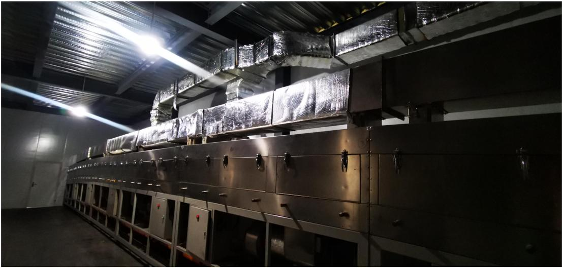
废气处理设施（颗粒物）（密闭负压管道收集+袋式除尘器+15m高排气筒P1）
